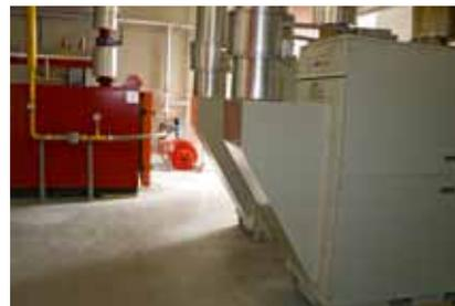
Mit zwei Mikrogasturbinen und einem Heizkessel werden die Trockenkammern beheizt.
