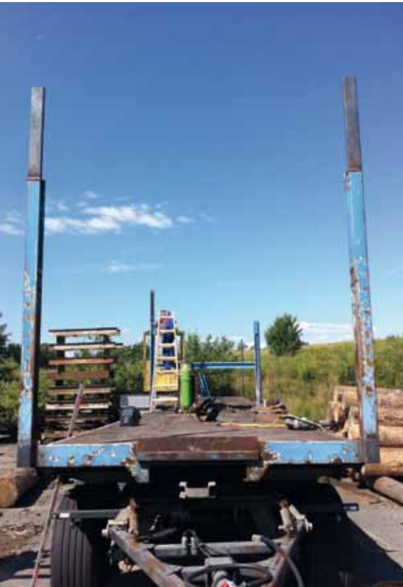
Zwei Anhänger und deren Grundrahmen bilden die Basis für den Aufbau des Holzriegelbaus, wobei Mario Rampitsch heute sogar auf einen Vollholzaufbau zurückgreifen würde.
