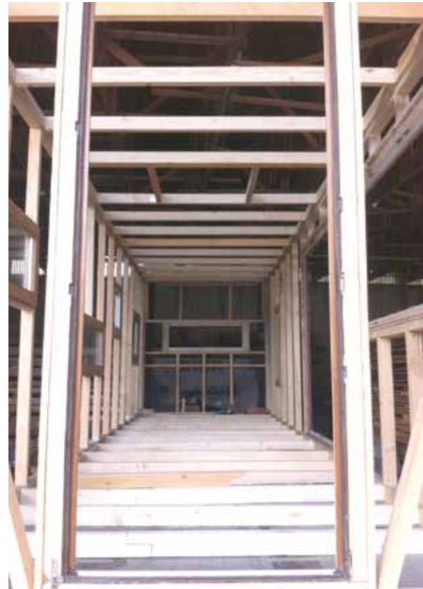
Zwei Anhänger und deren Grundrahmen bilden die Basis für den Aufbau des Holzriegelbaus, wobei Mario Rampitsch heute sogar auf einen Vollholzaufbau zurückgreifen würde.
