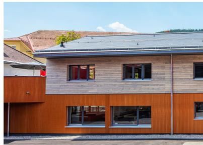
Die Tricoya-Platten wurden mit Teak furniert und anschließend mit dem dem Aquawood-Protor-System von ADLER beschichtet.
