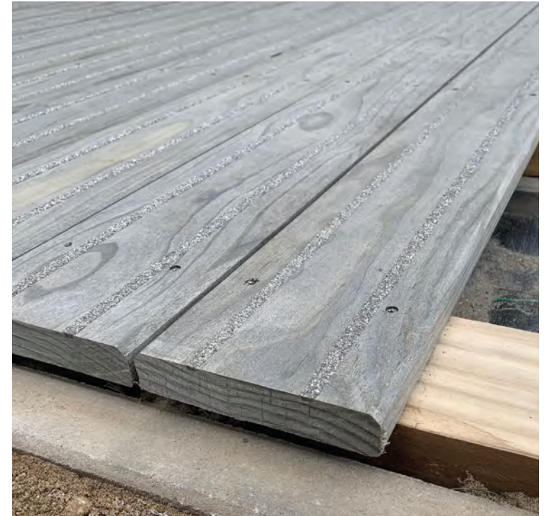
Accoya COLOR-Terrassendielen mit Gripsure Anti-Rutsch Einsätzen.
