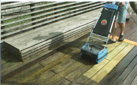
Reinigung einer stark verschmutzten Holzterrasse mit einer Bürstmaschine.
